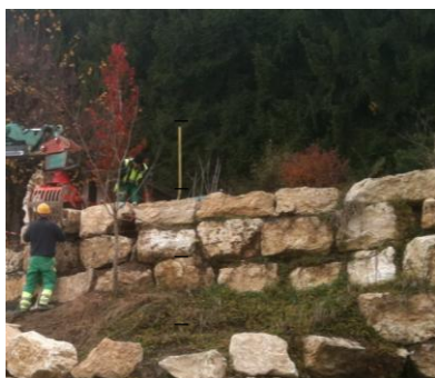
Enrochement de type cyclopéen interdit
